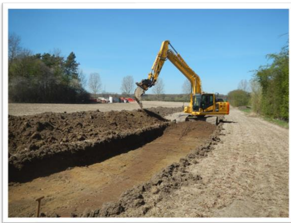
Figur 3: Mulden afrømmes i en maskinbredde. Nederst i billedet ses et rødt dækbånd fra et nedgravet elkabel, som bygherre ikke havde fået oplyst tilstedeværelsen af. Foto: Museum Sydøstdanmark.
